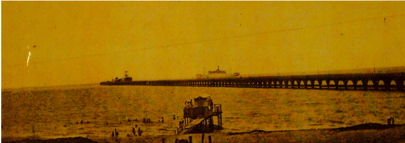
Fotografía 11. Muelle de Puerto Colombia, luego de finalizadas las obras de encamisamiento en concreto. Fuente: Archivo del Museo Romántico de Barranquilla.
