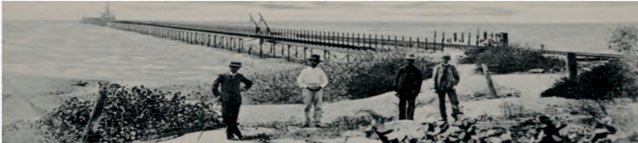
Fotografía 8. Muelle de Puerto Colombia construido en acero y madera de pino creosotado.
