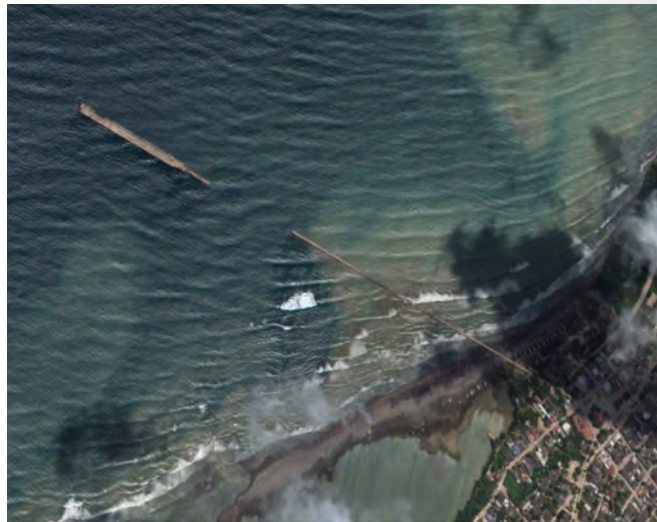
Fotografía 18. Colapso de los primeros 200 metros del Muelle de Puerto Colombia en 2009. Fuente. Google Earth.
