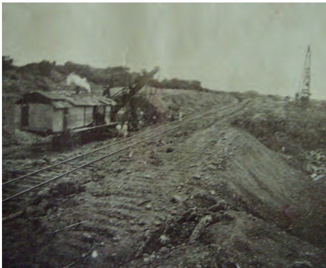
Fotografía 7. Obras de prolongación del Ferrocarril de Bolívar entre Sabanilla y Cupino. Fuente: Archivo del Museo Romántico de Barranquilla.
